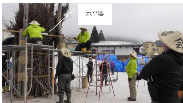
図4 社殿の桁材を固定する高さの位置決め
