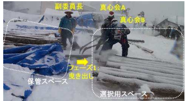
図4 フェーズ1「曳出し」
