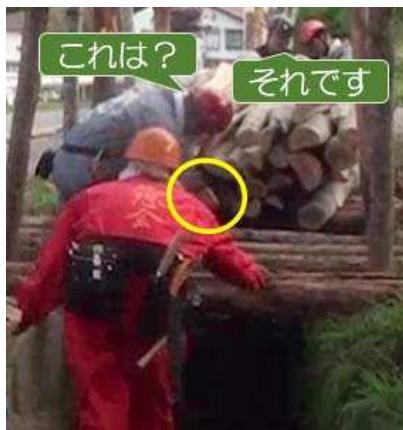
図 12-4 掛矢の柄の先で材木を突く
